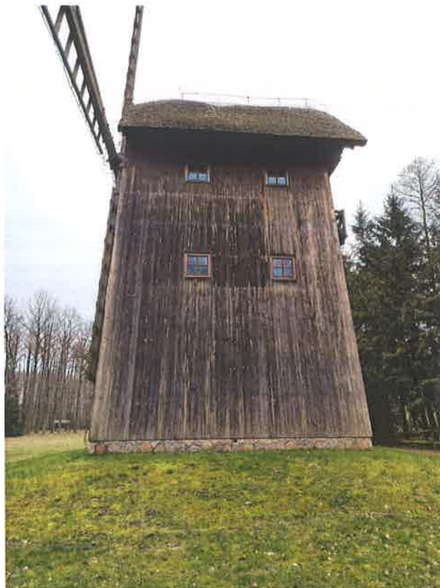
Fot.4. Widok na elewację zachodnią (opracowanie: własne)
