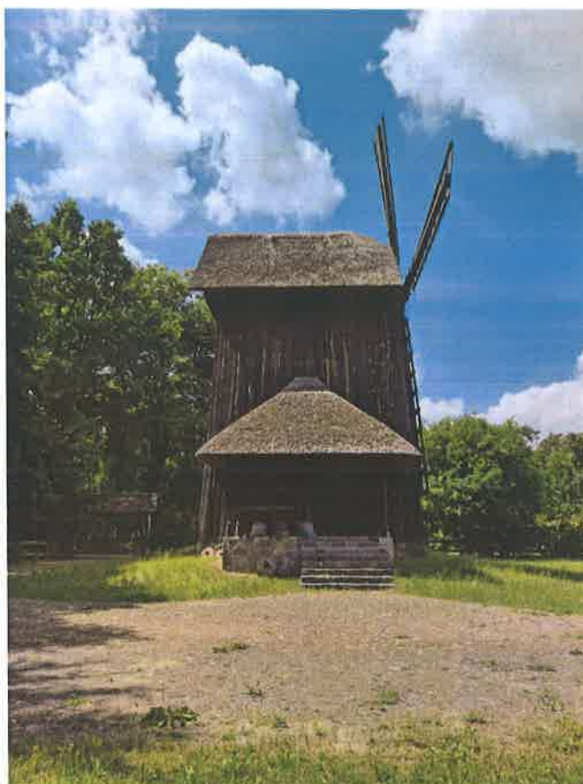
Fot. 1. Widok na elewację wschodnią – wejście główne do obiektu (opracowanie: własne)
