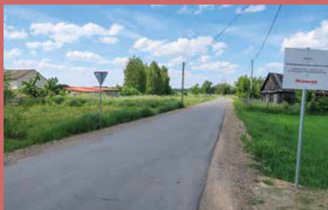
Modernizacja drogi gminnej w miejscowości Olędy na odcinku 995 m. Wartość zadania: 410 147,02 zł., dofinansowanie: 50 000,00 zł.
