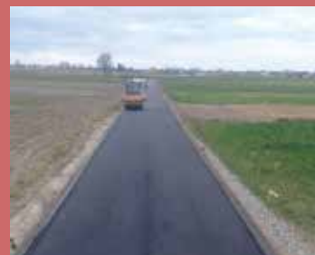
Modernizacja drogi gminnej nr 361316W w miejscowości Izdebki-Wąsy. Wartość zadania: 422 303,54 zł.
