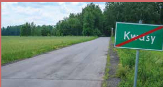
Modernizacja drogi gminnej nr 361311W Wólka Kamienna-Kwaszy o dł. 970 mb. Wartość zadania: 477 832,27 zł.
