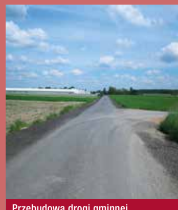
Przebudowa drogi gminnej w miejscowościach: Lucynów, Krzymosze. Wartość zadania: 159.500,00 zł.
