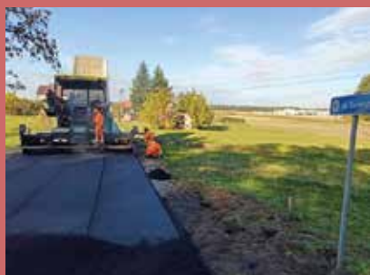
Przebudowa drogi gminnej ul. Zarzeczna w miejscowości Zbuczyn. Wartość zadania: 179 860,98 zł.
