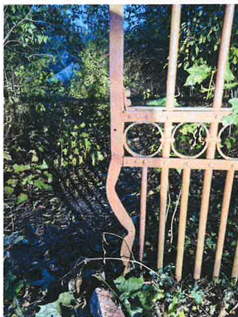
Widoczne zakrzywienie detalu architektonicznego, wymagające naprawy.
