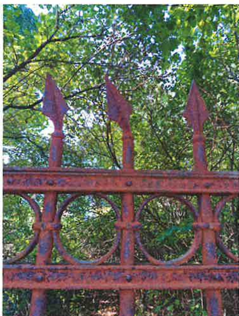
Widoczne zakrzywienie detalu architektonicznego, wymagające naprawy.
