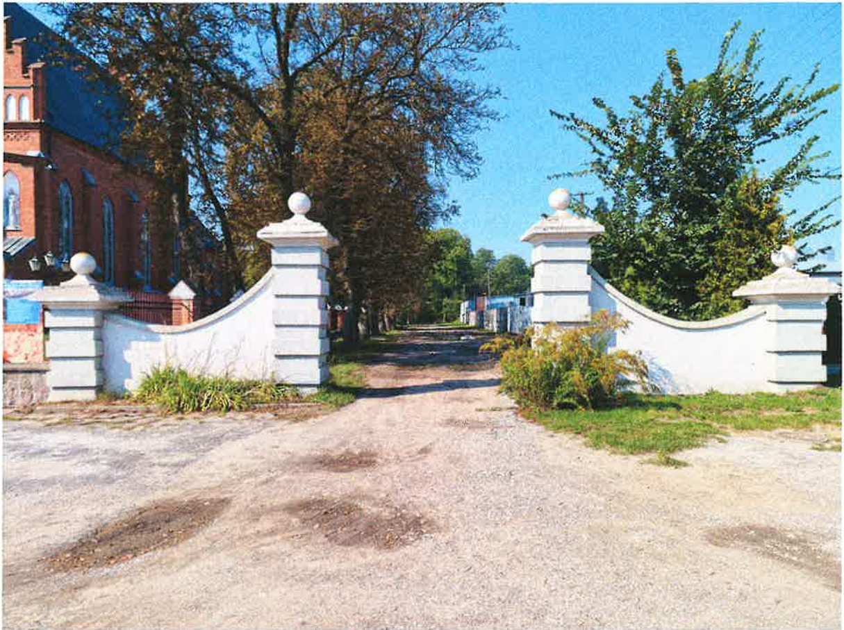
Widok na bramę wschodnią od strony frontowej.
