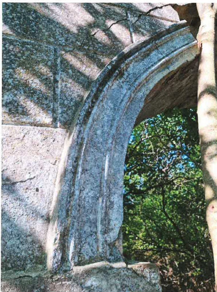
Detal oryginalnego gzymsu łukowego oraz części zachowanego boniowania. (widok od strony wschodniej).
