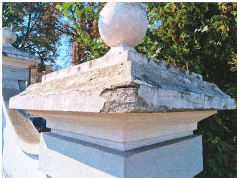
Widok na głowicę słupa mniejszego od strony północnej.
