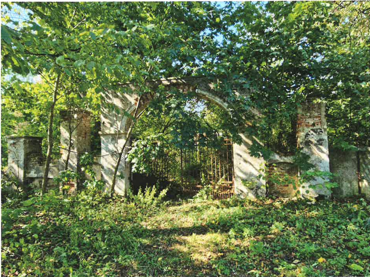
Widok na elewację wschodnią bramy.
