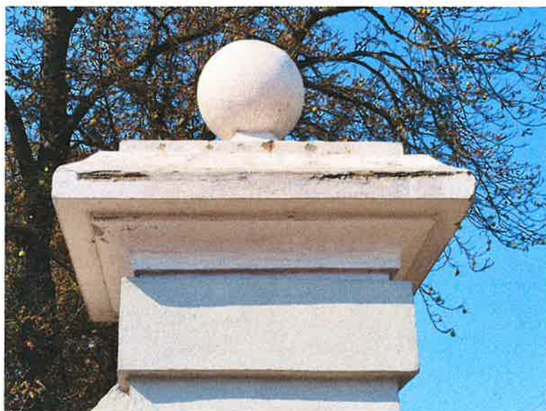
Głowica słupa wyższego, bramowego, południowego przęsła. (widok od strony wschodniej – frontowej)
