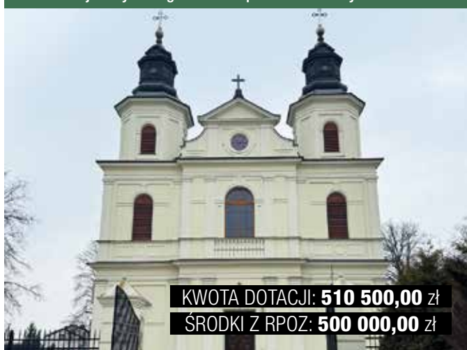
Modernizacja zabytkowego kościoła i plebanii w Zbuczynie
