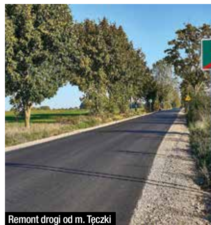
Remont drogi od m. Tęczki
